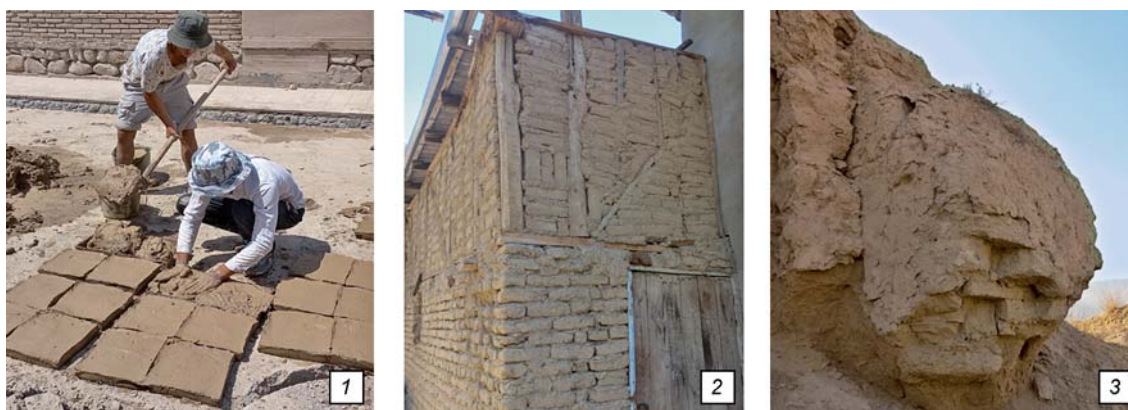
Рис. 7. Строительство из саманного кирпича. Таджикистан. Фото Н. Петровой.
