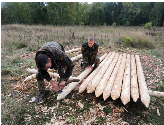
Рис. 3. Экспериментальное изготовление тыновин Умревинского острога.
