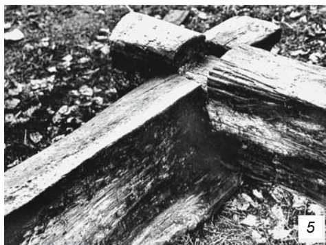
Рис. 2. Примеры повенцовой фиксации способов вязки бревен в углах сруба. Верх-Кальджин-2, кург. 1.
