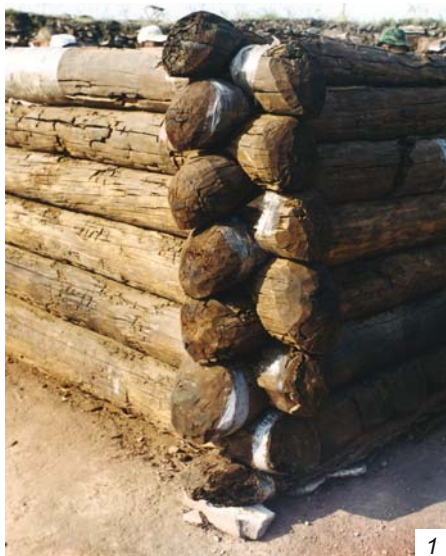
Рис. 5. Торцы бревен северного угла сруба (1), отеска «в лас» и на- клоны плоскостей отесанных бревен внутри сруба (2). Аржан-2, погр. 5.
