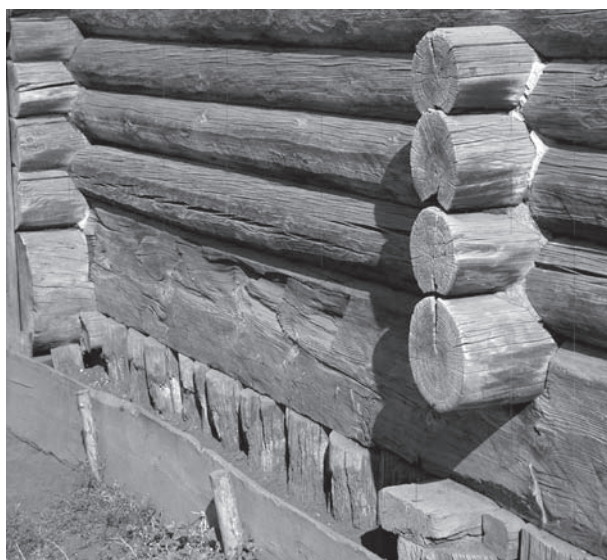
Рис. 14. Ленточный свайно-столбчатый фундамент жилого дома середины XX в. на севере Верхнего Приобья (с. Юрт-Акбалык Колыванского р-на Новосибирской обл.).
