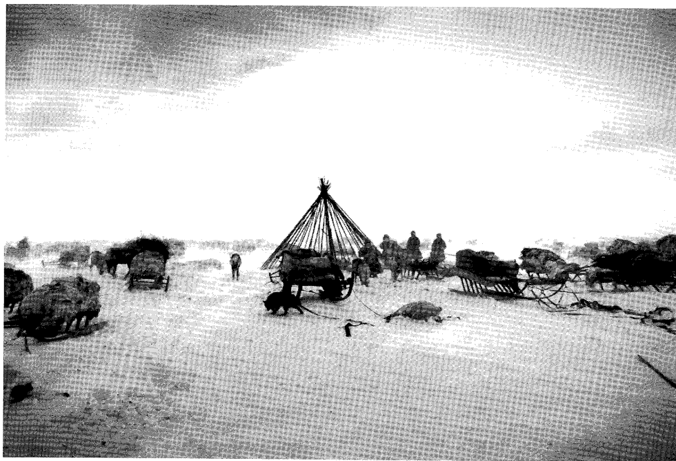
14. Ненецкий чум сделан из деревянных жердей, покрытых пологом, сшитым из оленьих шкур. Такой дом – теплый и легкий – можно разобрать и упаковать в нарты за очень короткое время.
