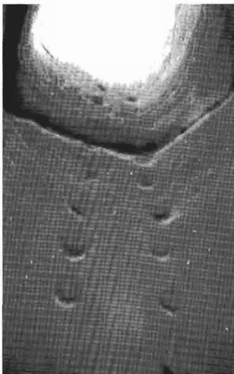
Рис. 3. Ствол вертикальной шахты на плато Мясниковского (IV) участка; хорошо видны сохранившиеся ступени на стенке ствола.
