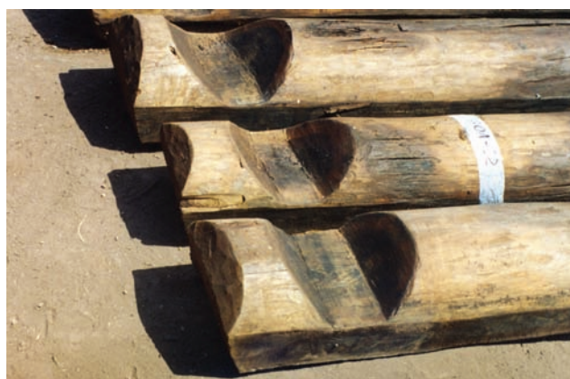
Рис. 49. Бревна окладного венца и настила пола, подготовленные к экспресс-реконструкции внутреннего сруба из могилы 5 кургана 2 могильника Аржан. 1 – бревна нижнего (окладного) венца внутреннего сруба; 2 – полубревна настила пола; 3 – чашки полубревен пола для опоры на окладной венец.
