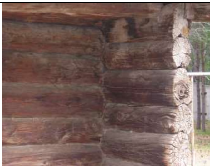
Рис. 14. Угол бурятской юрты, вырубленный в обло. ЭМНЗВБ, Улан-Удэ, 2007. Фото А. А. Бадмаева.
